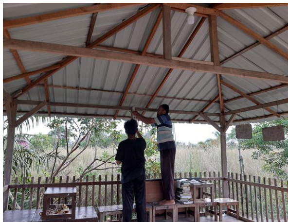
Gambar 5. Pemasangan Saklar dan CB di ruang belajar outdoor .
