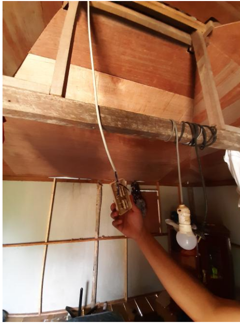
Gambar 7. Kondisi Existing Lampu dan Stop Kontak Kamar Guru
