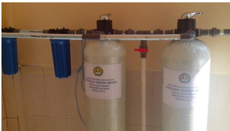
Gambar 9. Hasil Pemasangan Penyaring Air
