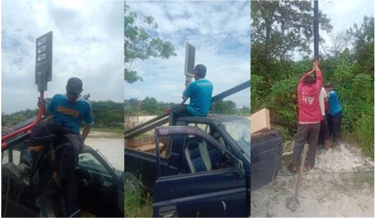
Gambar 7 Pemasangan lampu All Ini One PJU Tenaga Surya
