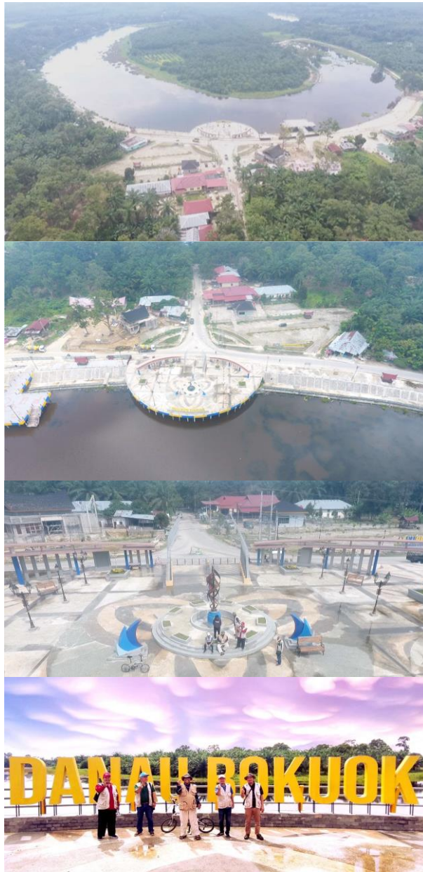
Gambar 2. Penampakan hasil foto udara (drone) Plaza Danau Bakuok
