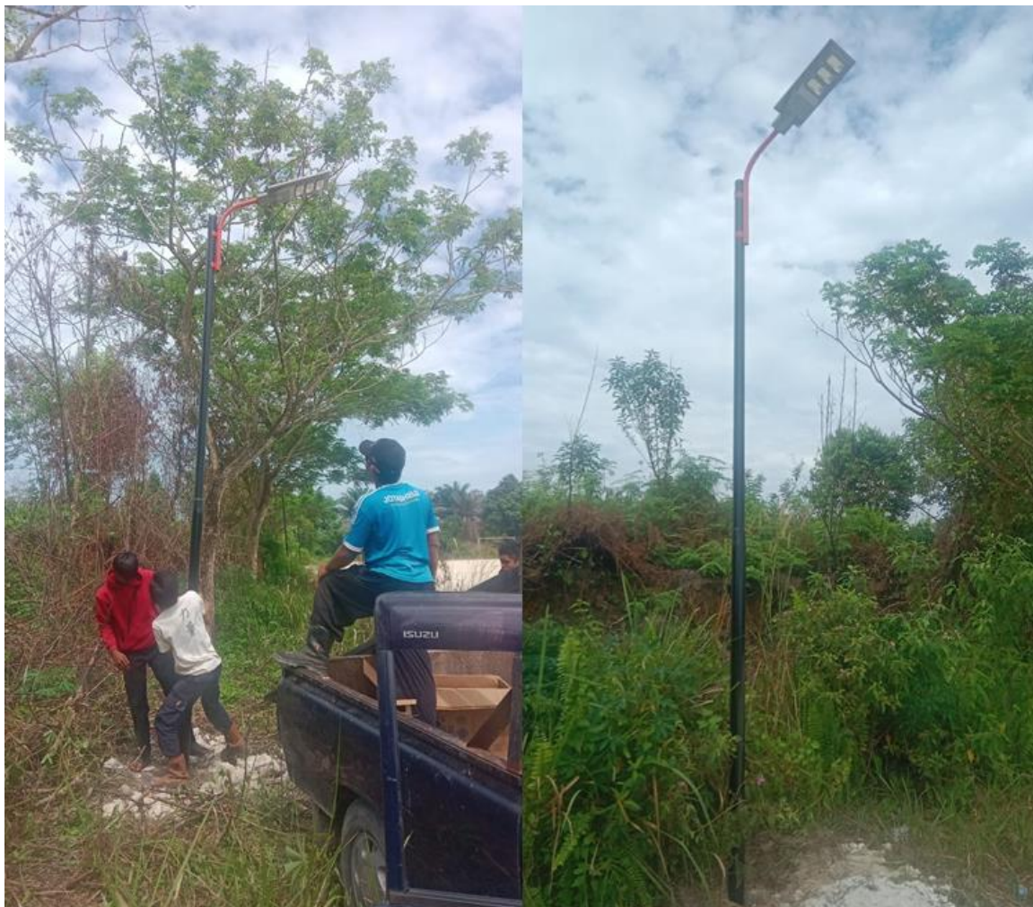
Gambar 8 Hasil Pemasangan lampu All Ini One PJU Tenaga Surya
