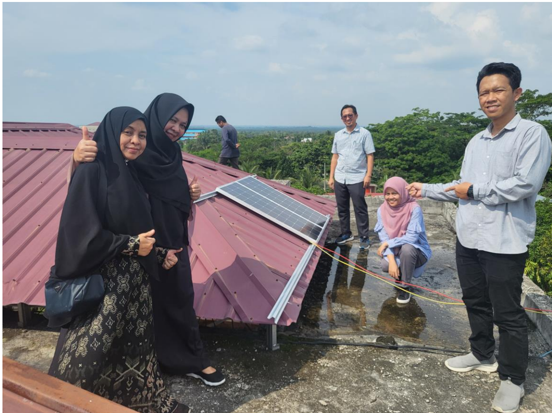
Gambar 4 Tim saat pemasangan solar panel di atas gedung asrama ponpes
