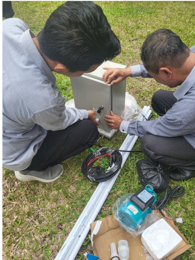
Gambar 5. Proses perakitan sistem pompa air tenaga surya
