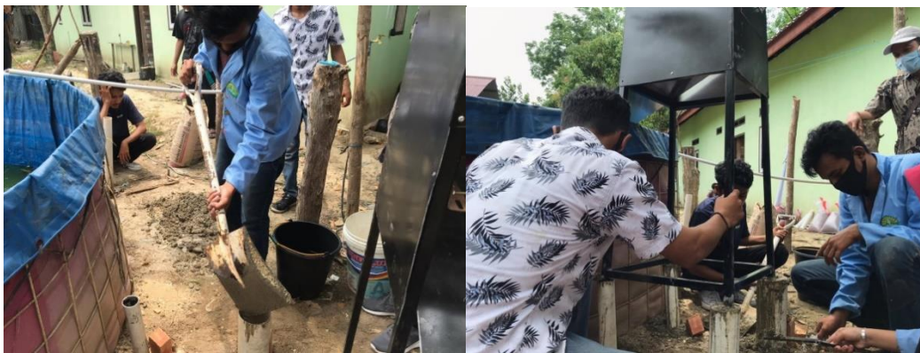
Gambar 13 Pembuatan pondasi peletakkan alat
