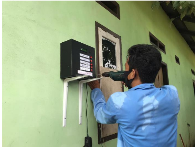
Gambar 12 Pemasangan Panel
